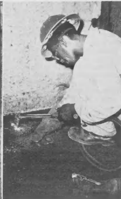
RIGGERNAN TA usa un chain block pa move un pida staal di tres ton for di e fundeshi di Combination Unit No. 5, robes. Un buraco ta worde cortá, centro, pa yuda den ponemento di e chain block. Nasario Tromp, Foreman di Metal Trades, drechi, ta inspecta e progreso.
